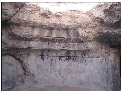
شکل ۳. کنده کاری در بدنه سنگی و ایجاد فضایی گنبدی شکل با آرایه قطاربندی (فضای V6)
