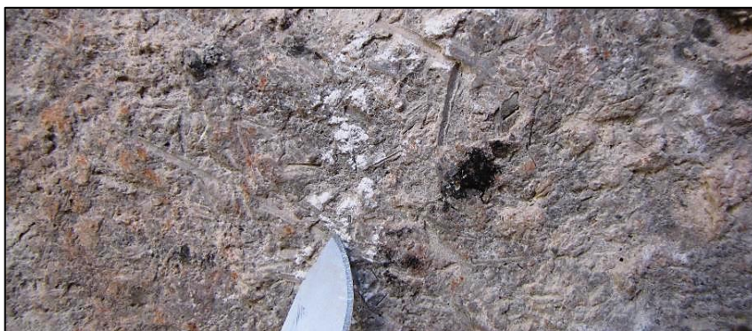
شکل ۵. ملاط خاکستری با الیاف گیاهی در زیر ملاط قرمز-قهوه‌ای در ازاره فضای
