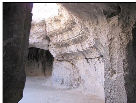
شکل ۳. کنده کاری در بدنه سنگی و ایجاد فضایی گنبدی شکل با آرایه قطاربندی (فضای V6)
