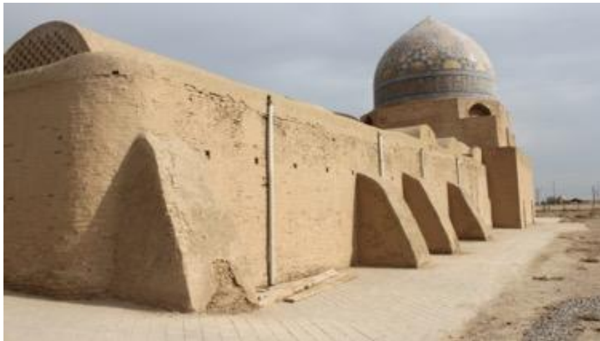
شکل ۲. باروی جنوبی مسجد، تقویت‌های دوره‌های بعد و عقب‌نشینی آن در دوره صفوی برای برپایی گنبدخانه جدید (نگارنده، ۱۳۸۹)
