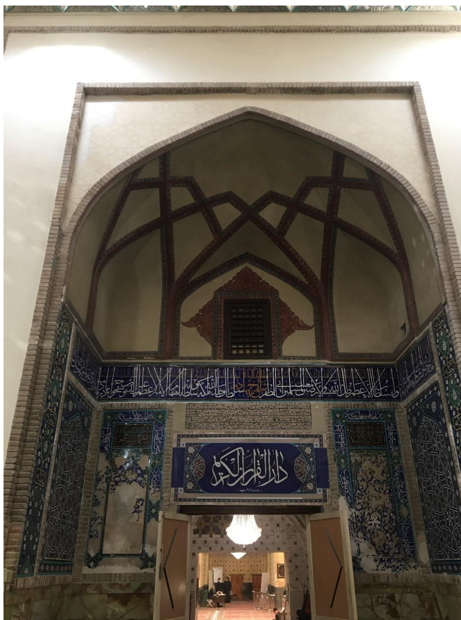
شکل ۲. وضعیت پیشین سردر مدرسه دودر پیش از آغاز مرمت. جبهه ایوان تماماً با گچ پوشیده شده و هیچ آرایه‌ای ندارد.
