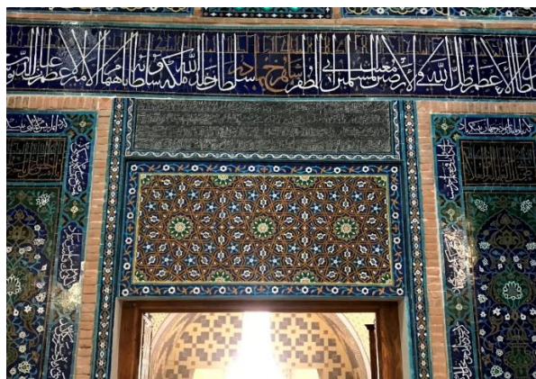
شکل ۱۸. طرح جدید جهت آرایش مستطیل بالای در مدرسه دودر، مطابق با الگوی دوره تیموری، پس از پر کردن پس‌نشستگی خفنگ، عکس از نگارنده.
