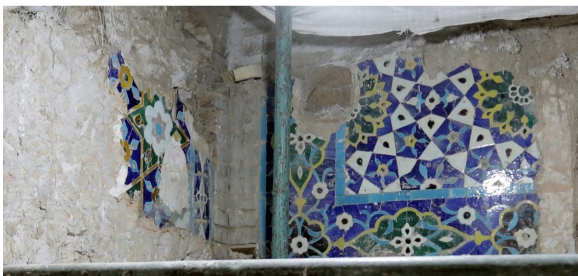
شکل ۱۲. بقایای کاشی‌های اصیل سردر که در گوشه سمت راست اسپر (بالای در) و گوشه زیردور به جا مانده است و مبنای بازسازی نقش گره اسپر قرار گرفت. عکس از نگارنده.
