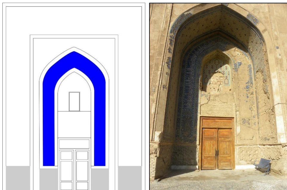
شکل ۴. سردر مدرسه غیاثیه خرگرد و آنالیز خطی ساختار قاب کتیبه درون آن، عکس از نگارنده
